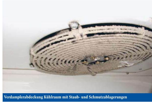
Verdampferabdeckung Kühlraum mit Staub- und Schmutzablagerungen
