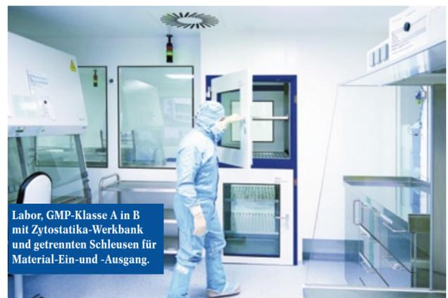
Labor, GMP-Klasse A in B mit Zytostatika-Werkbank und getrennten Schleusen für Material-Ein- und -Ausgang.
