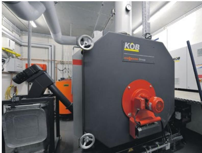
Mit einer Leistung von 300 kW deckt ein innovativer Pelletkessel, der sich durch eine patentierte Rotationsfeuerung und einen hohen Wirkungsgrad auszeichnet, rund 90 % des Wärmebedarfs des Seniorenzentrums ab.
