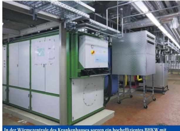
In der Wärmezentrale des Krankenhauses sorgen ein hocheffizientes BHKW mit 390 kW thermischer Leistung sowie ein Gasbrennwertkessel für die Abdeckung der Wärmegrundlast.
