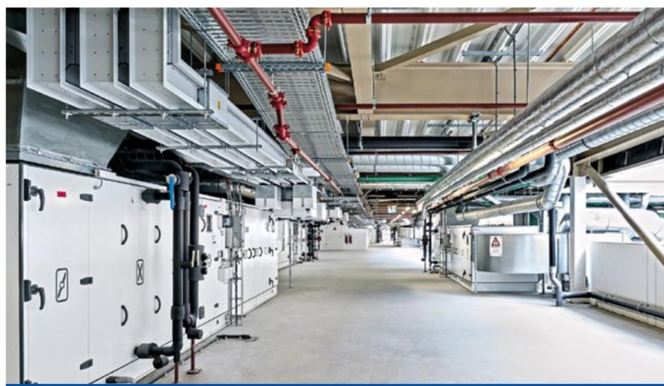
RLT-Geräte mit höchsten Anforderungen an die Luftreinheit versorgen den OP-Bereich mit angrenzender Intensivstation. Intelligente MSR-Technik stellt geforderte Luftparameter und Luftbilanzen in den hochsensiblen Bereichen sicher.
