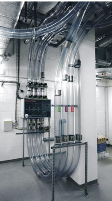
Die „Zentrale“ der Rohrpostanlage
