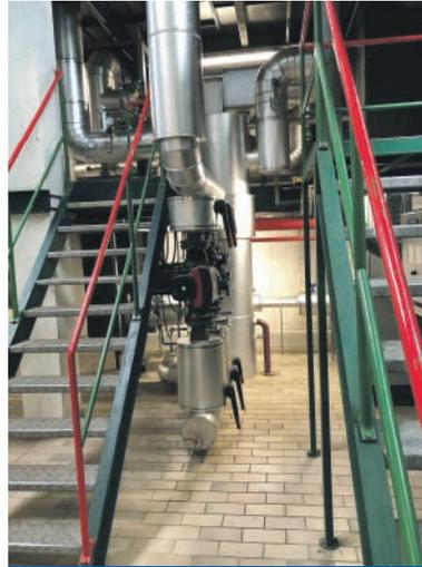
Wärmeübertrager mit Sekundärwälzpumpen
