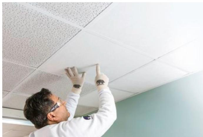
Sauber, schnell und überzeugend: Mit CapaCoustic RasterFiXX gelingt die Renovierung von Akustikdecken ohne Beeinträchtigung der Schallabsorption. Die neuen RasterFiXX-Platten gibt es für das Deckenraster 62,5 x 62,5 cm. Das System kann für alle Deckensysteme mit gerader Kantenausführung verwendet werden.
