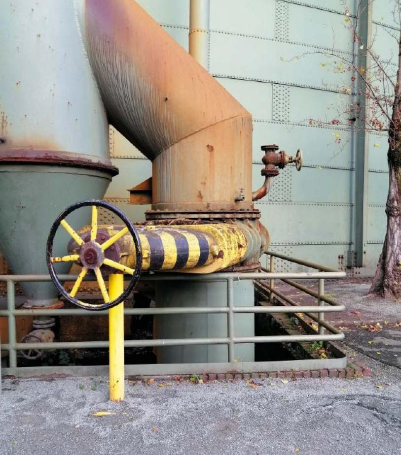
Hand-Drehventil mit signalhaften Farben, die in Kombination von Gelb und Schwarz eine Warnung vor ätzenden Stoffen sowie radioaktiven und ionischen Strahlen signalisieren.
