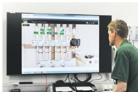
Energieelektroniker Hagen Bärhold kann über die vernetzten „AquaVip-Zirkulationsregulierventile elektronisch“ und die browsergestützte Viega-Software die Temperaturhaltung in den Zirkulationssträngen vom Schreibtisch aus überwachen.
