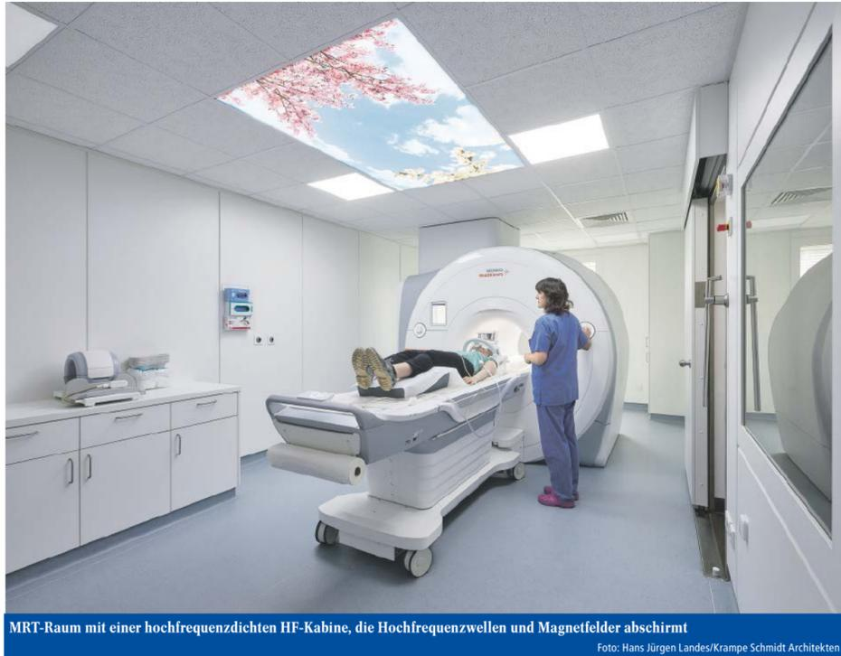
MRT-Raum mit einer hochfrequenzdichten HF-Kabine, die Hochfrequenzwellen und Magnetfelder abschirmt
