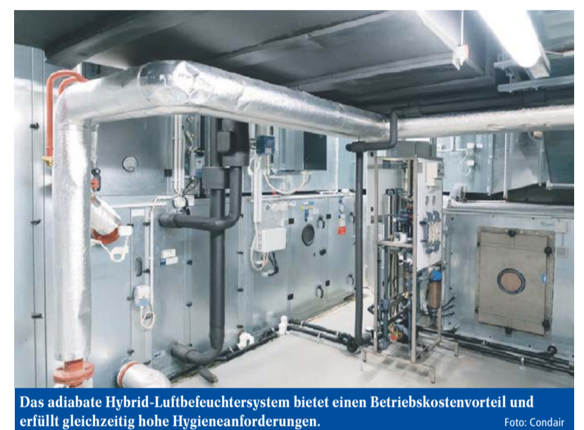
Blick ins Innere des adiabaten Hybrid-Luftbefeuchters
