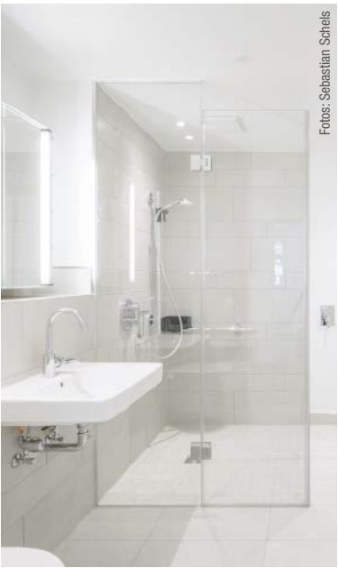
Komfort und Sicherheit beim Duschen: Die Thermostataratur beugt Verbrühungen vor, bei der Handbrause kann komfortabel zwischen den Strahlarten gewählt werden.
