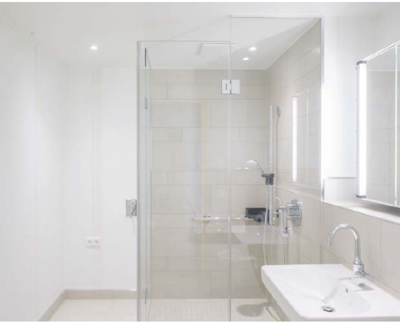
Die barrierefreien Bäder sind mit unterfahrbaren Waschtischen ausgestattet und bieten viel Bewegungsfläche. Die Armaturen ermöglichen eine seidenweiche Bedienung.
